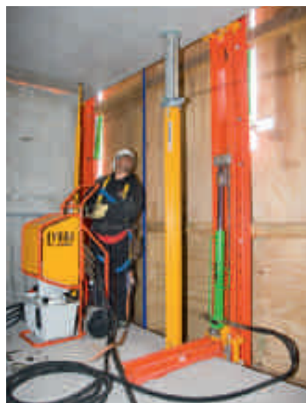
Перемещаемые модули могут подниматься вверх со скоростью 1 м/мин.
