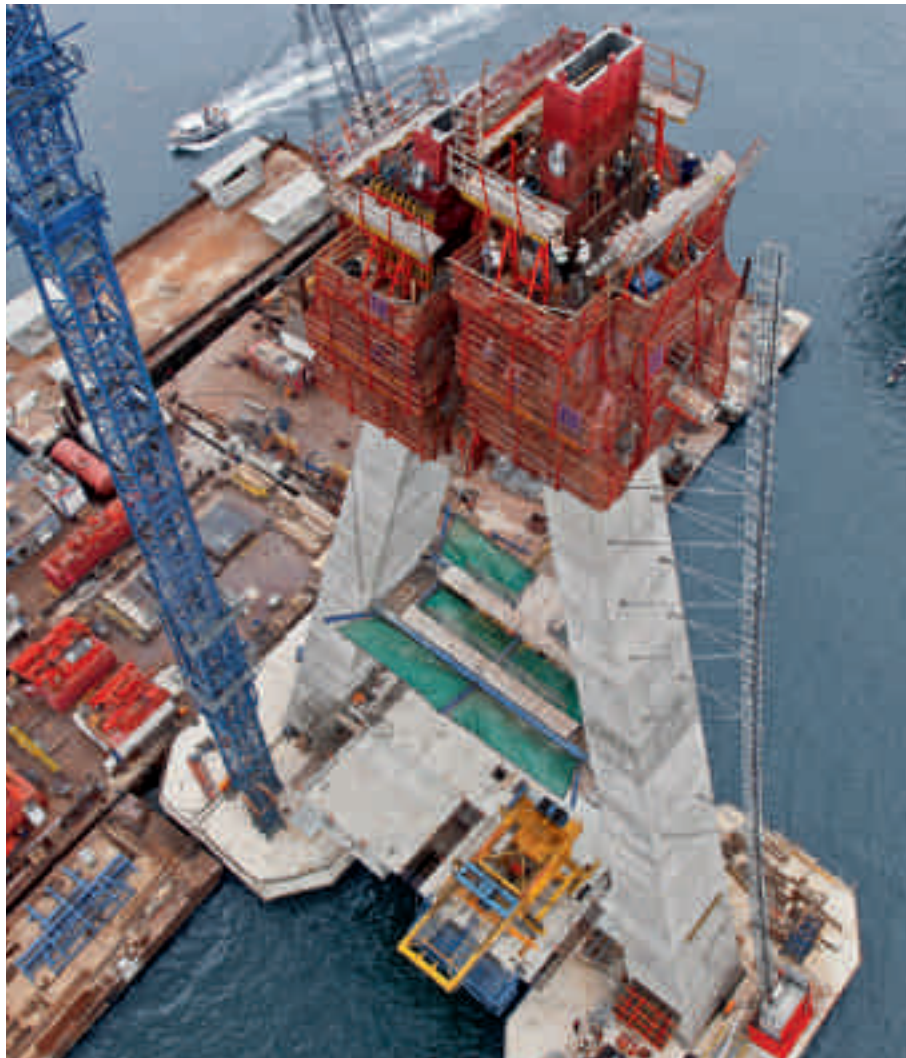
Для пилона моста в Нигерии компания PERI скомбинировала системы ACS и RCS. Строительство велось поэтапно и без крана, несмотря на постоянно изменяющийся наклон пилона.
