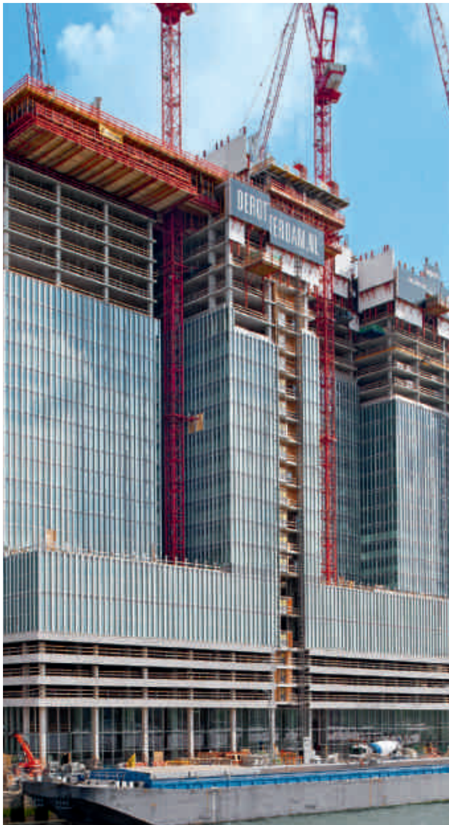
De Rotterdam, Роттердам, Нидерланды Подъемное защитное ограждение RCS P обеспечило максимальную защиту и возможность быстрого выполнения работ на двух верхних возводимых этажах. Важной составной частью решения PERI была специальная несущая конструкция VARIOKIT для поддержки выступающих до 9 м этажей, по высоте расположенных в середине здания.
