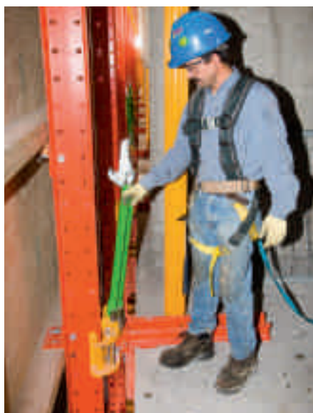
Гидравлический цилиндр с грузоподъемностью 5 т устанавливается на подъемный башмак.
